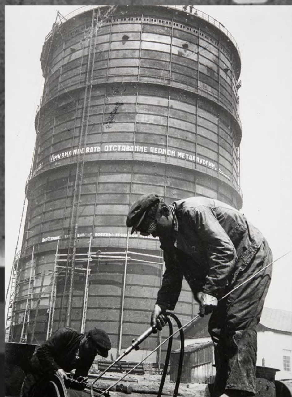
На строительстве газгольдера, 1934 г.
