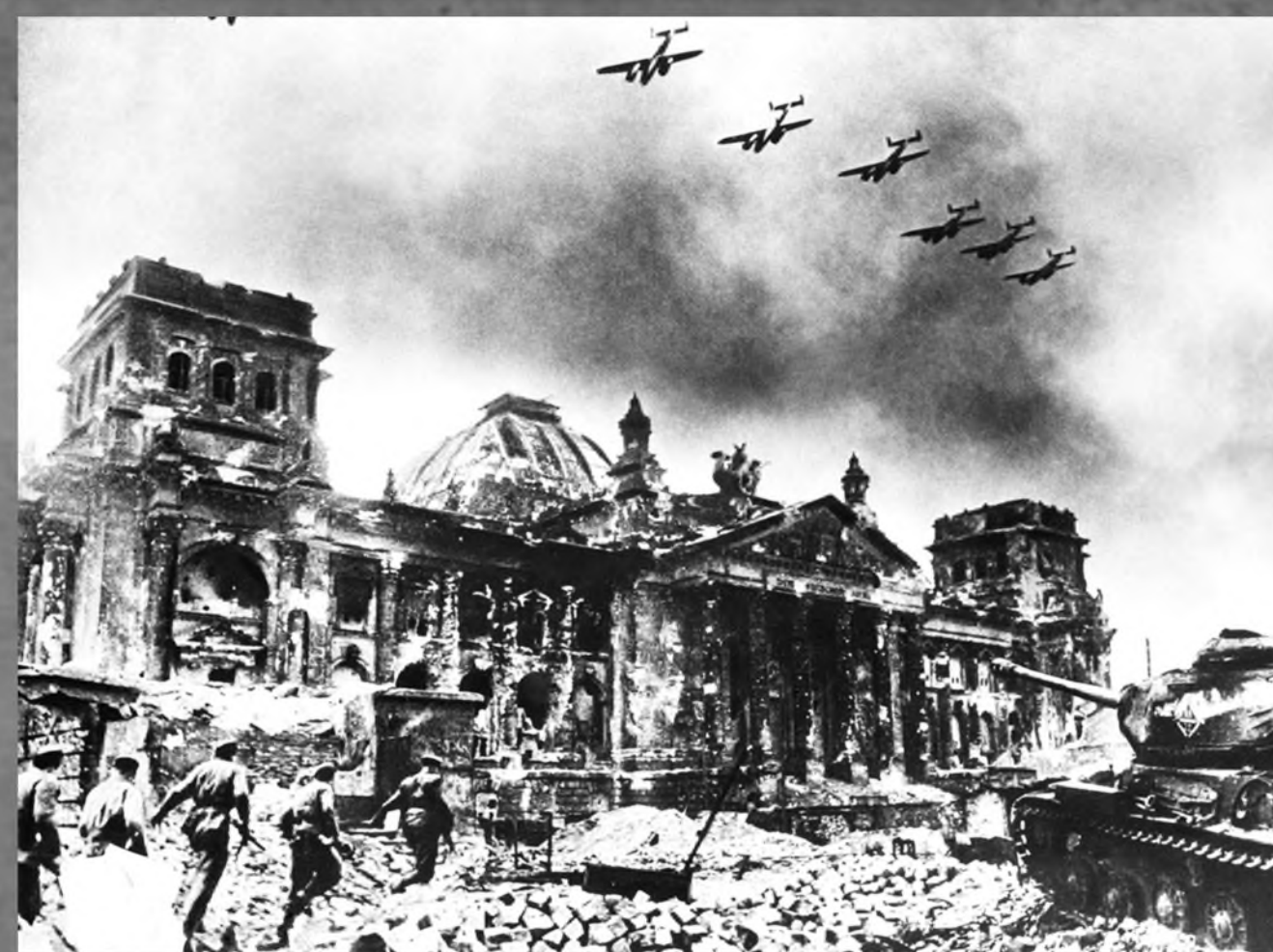
Разрушенный Рейхстаг. г. Берлин, май 1945 г.
