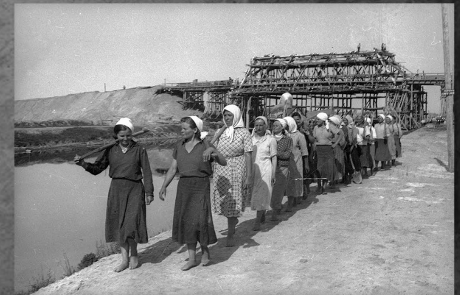
На строительстве Днепро-Бугского канала, 1939 г.
